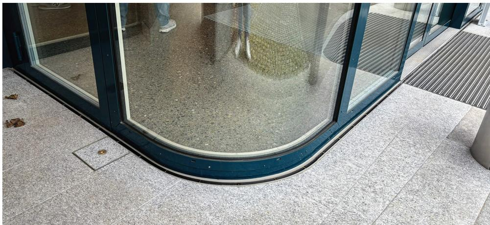
La gouttière ACO RSR a été fabriquée sur mesure et s'adapte parfaitement au rayon de la porte d'entrée.
