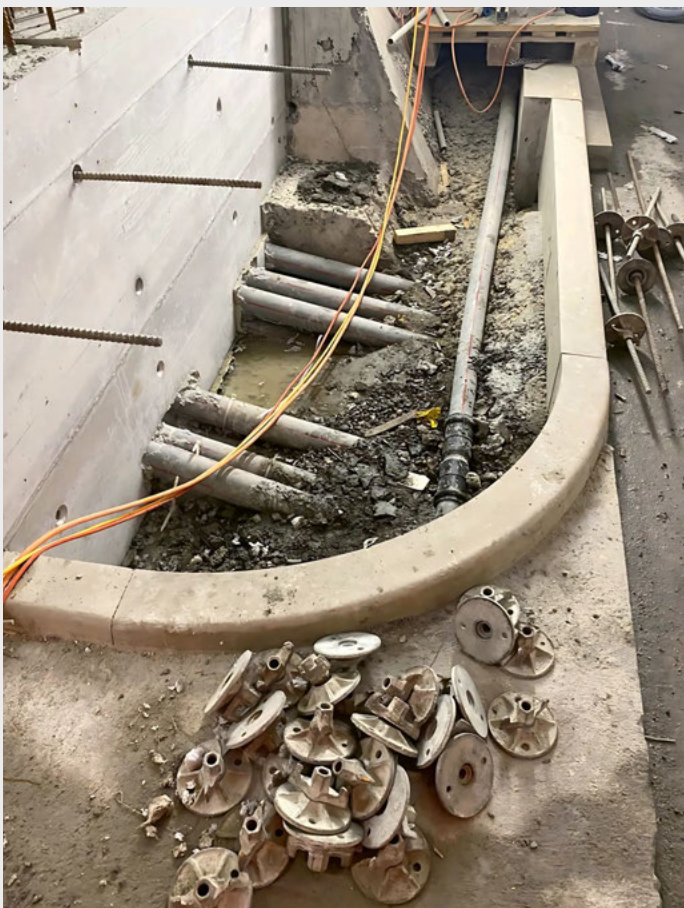
ACO Randsteine werden im Tunnel montiert.
