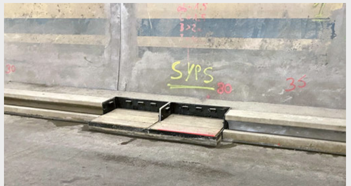
Einbau der Schlitzrinne und des Syphonschachtes.
