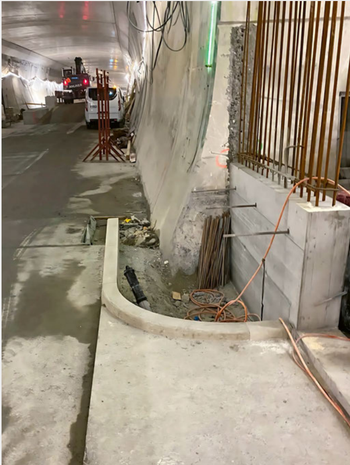
Einbau der Randsteine.
