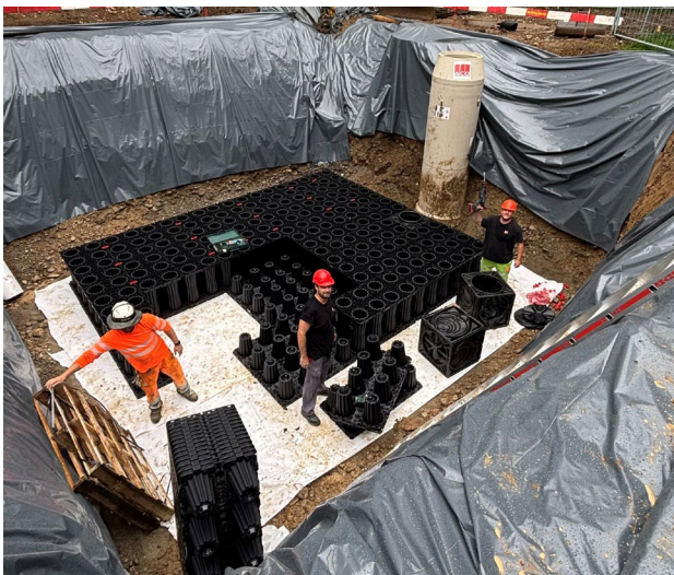
Installation du système de rigoles en blocs ACO Stormbrixx
