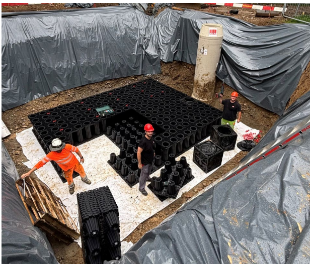
Installazione del sistema di canalizzazione a blocchi ACO Stormbrixx
