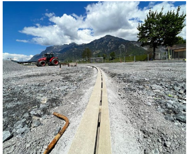
Einbau der ACO Sport Schlitzrinne
