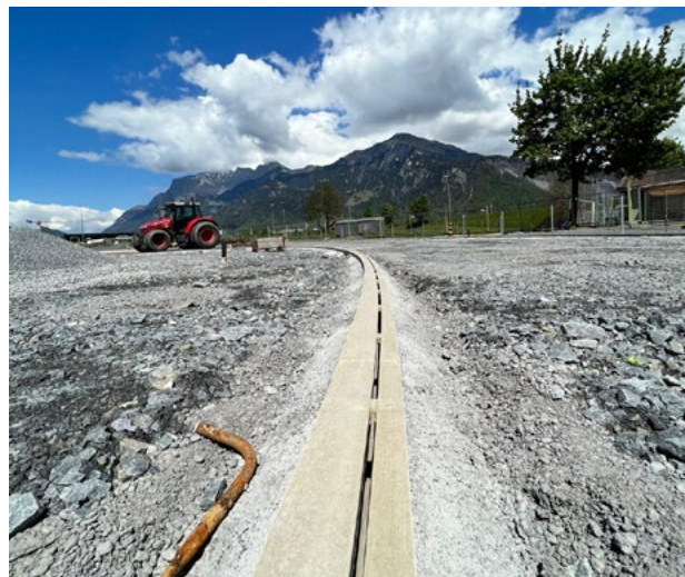
Installation du caniveau à fente ACO Sport
