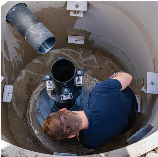
Der Einbau des technischen Filters
