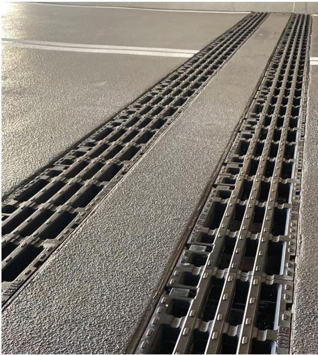
I canali ACO SwissDrain garantiscono un drenaggio sicuro ed efficiente nell'area del parcheggio multipiano.
