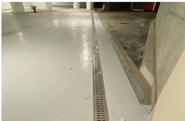
Canale in acciaio inox appena posato nel garage sotterraneo
