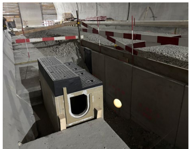
Siphonschacht mit ACO Guss-Stufenabdeckung
