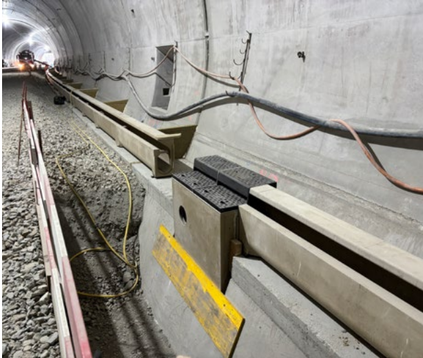
Pose du caniveau à fente pour tunnel ACO de type « Uetliberg »
