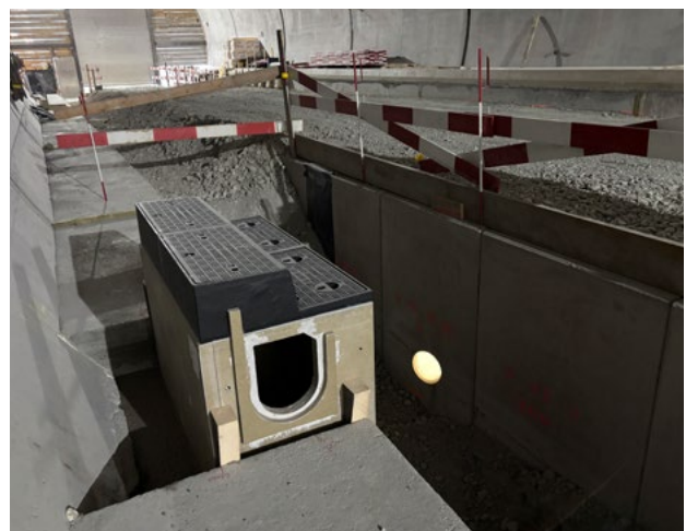
Puits de siphon avec couvercle à gradins en fonte ACO
