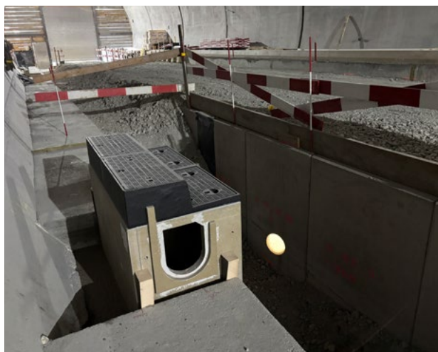
Pozzetto a sifone con copertura a gradini in ghisa ACO
