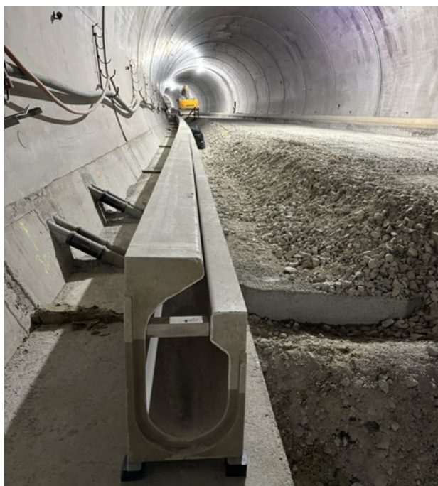
Installazione della canaletta a fessura per gallerie ACO tipo «Uetliberg»
