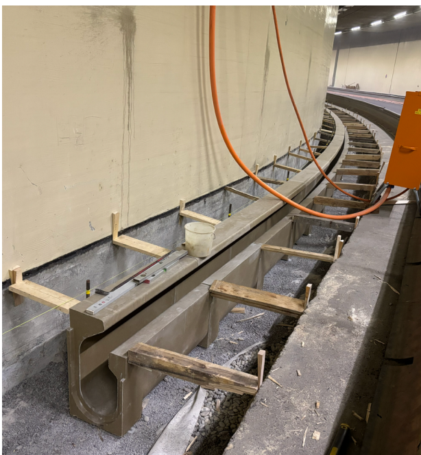
Verlegung der ACO Tunnelschlitzrinne UETLIBERG
