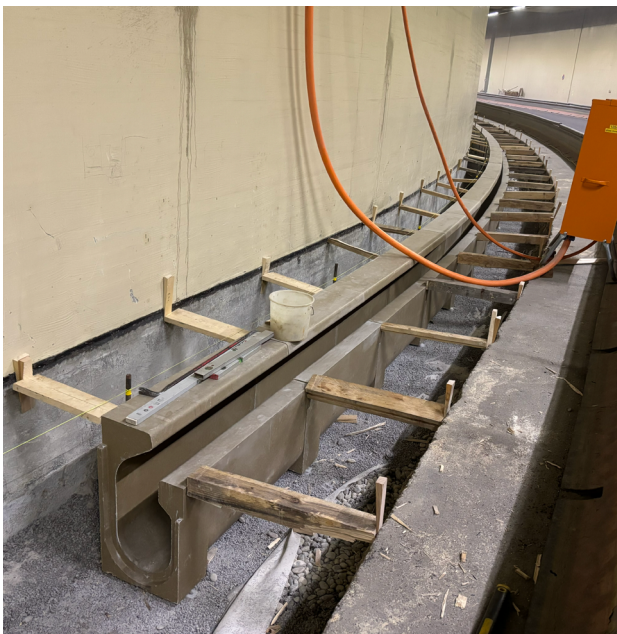
Pose du caniveau à fentes pour tunnel ACO UETLIBERG
