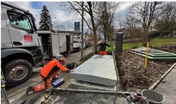
Montage der neuen Sonderschachtabdeckung beim Treppenabgang
