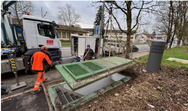
Demontage der bisherigen Abdeckung beim Treppenabgang
