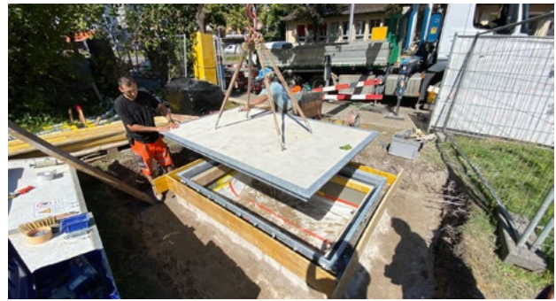
Montage der Sonderschachtabdeckung beim Transportschacht
