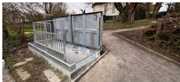
Nouveau couvercle spécial au niveau de la descente d'escalier
