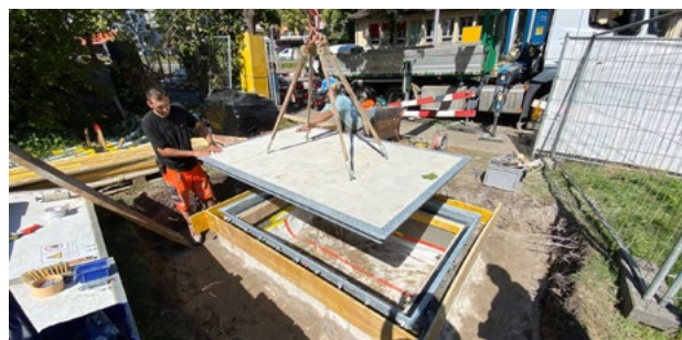
Montage du couvercle spécial au niveau du puits de transport
