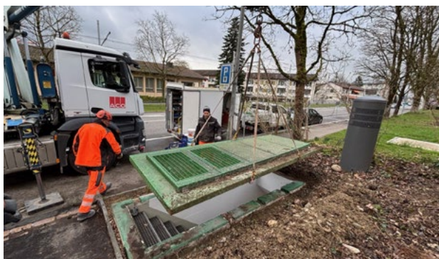
Démontage de l'ancien couvercle au niveau de la descente d'escalier
