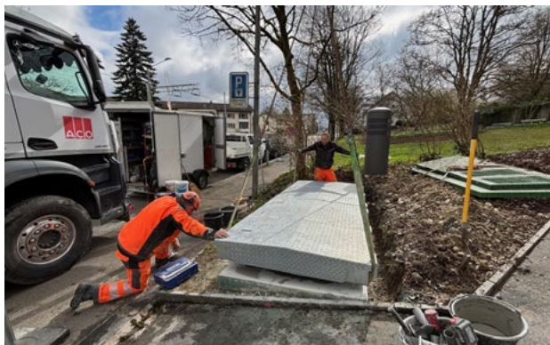
Montaggio della nuova copertura speciale del pozzo presso la scala di accesso
