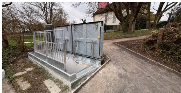
Nuova copertura speciale del pozzo presso la scala di accesso
