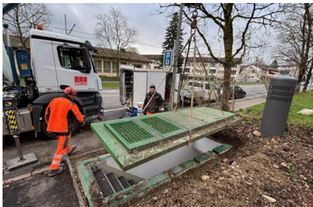
Smontaggio della precedente copertura presso la scala di accesso
