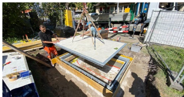
Montaggio della copertura speciale del pozzo presso il pozzo di trasporto
