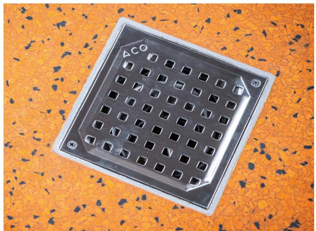
Die EG 150 Bodenabläufe im Einsatz in den Dusczonen
