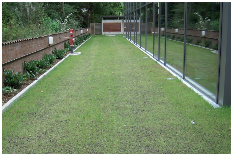
Les surfaces vertes peuvent être stabilisées de manière perméable à l'eau et carrossable pour les véhicules d'entretien avec le Dalles à engazonner ACO Grass.
