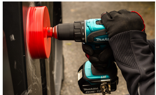
Réaliser un trou en bas du réservoir pour le raccordement de l'étrangleur de rétention à l'aide d'une scie circulaire à trous.
