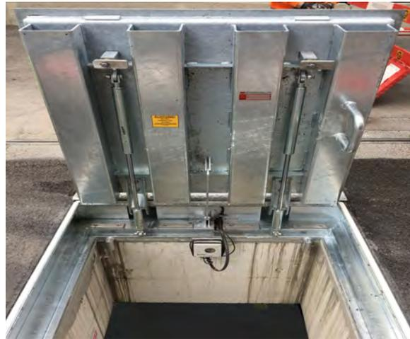
Sortie de secours avec chauffage du joint et thermostat
