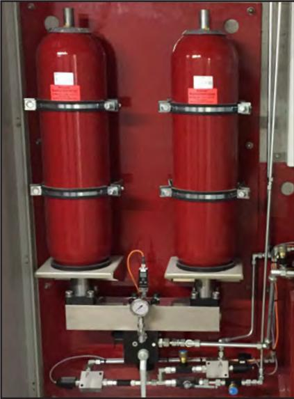
Accumulateur de pression pour ouverture de secours en cas de coupure de courant
