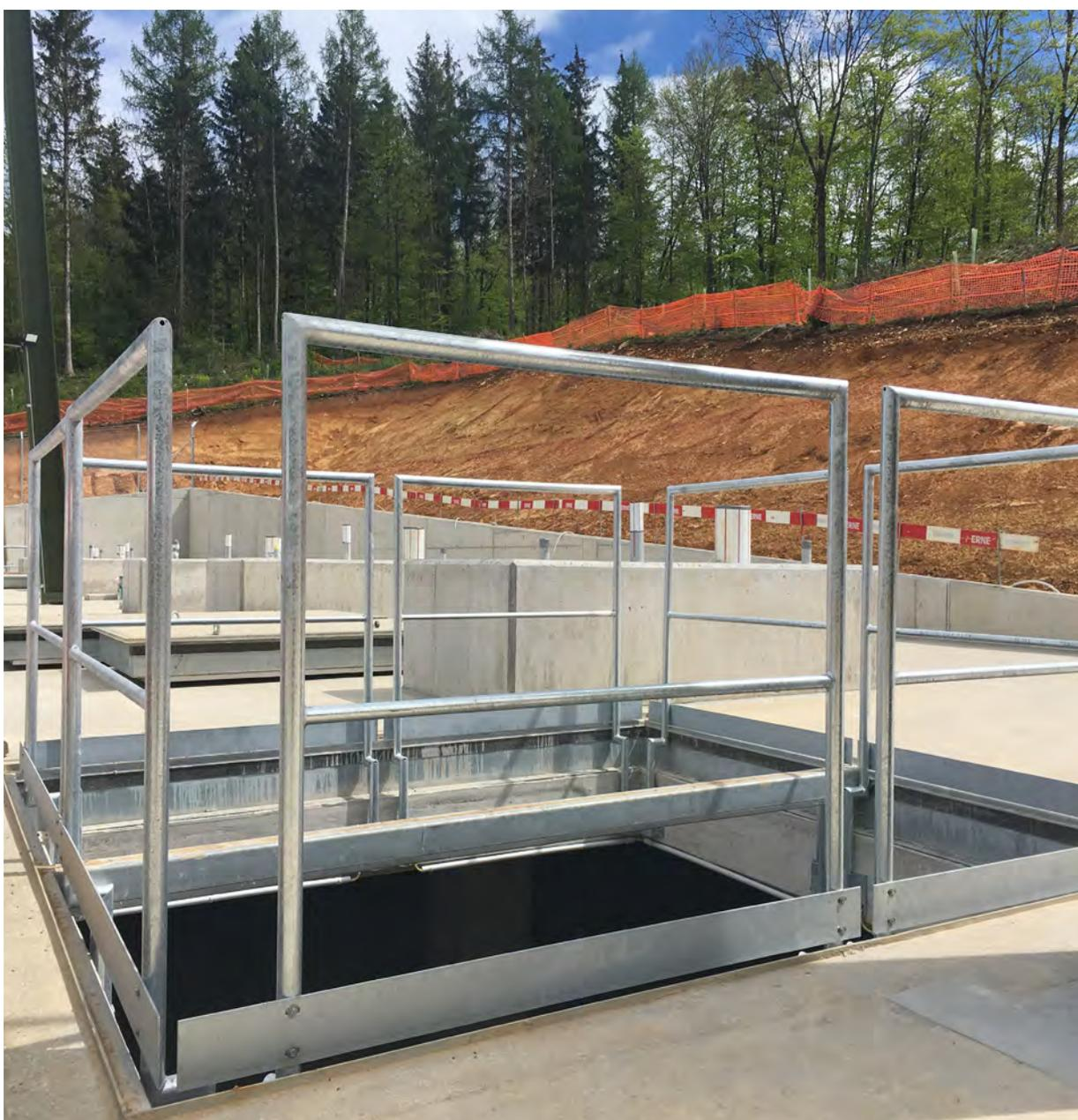
Trappe à deux battants avec traverse démontable et garde-corps amovible
