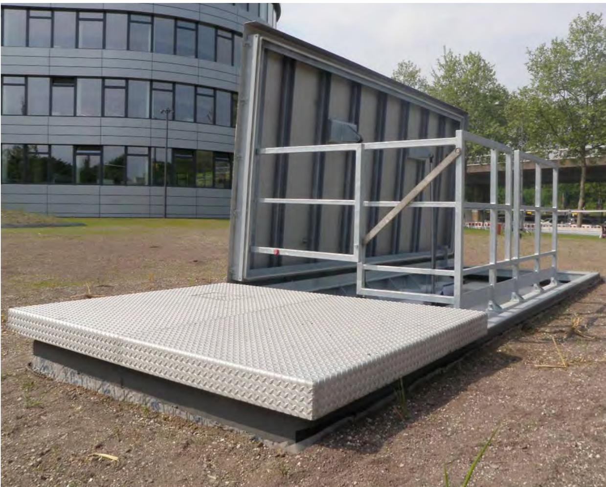
Sortie de secours posée sur l'ouvrage
