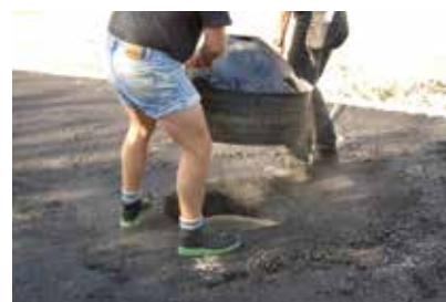
Retirer le coffrage avec précaution en le tirant
