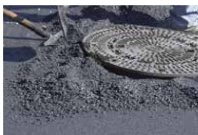
Mettre à niveau de la surface environnante avec du bitume chaud
