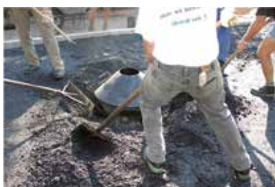
Placer le coffrage dans l'anneau d'adaptation, couler le bitume et bien compacter
