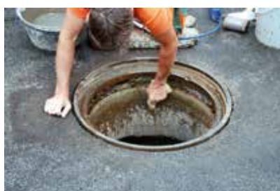
Nettoyer le cadre soulevé et l'humidifier
