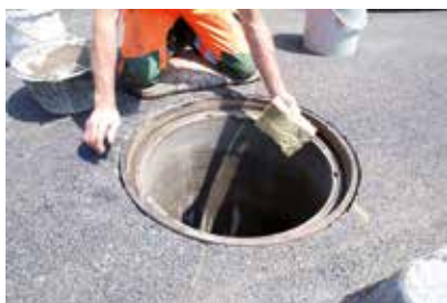
Sortir et nettoyer le coffrage
