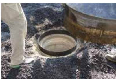
Dégager le regard, enlever la plaque d'acier, placer l'anneau adaptateur
