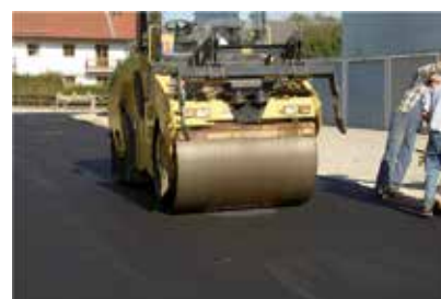
Cylindrer le regard jusqu'à ce qu'il affleure avec la chaussée
