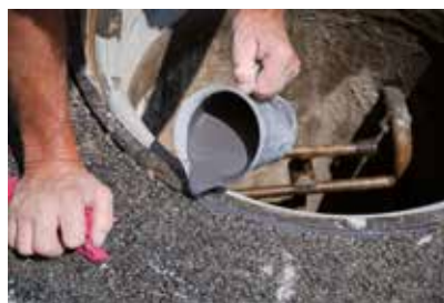
Finaliser la rainure entre le cadre et le revêtement de la chaussée
