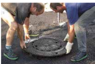
Mettre le regard complet en place
