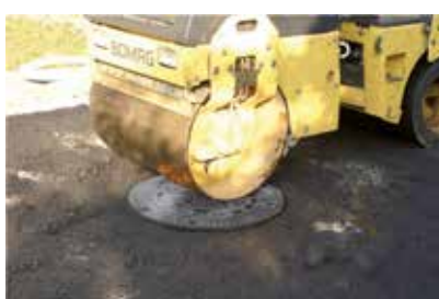
Cylindrer le regard de manière qu'il affleure avec la chaussée
