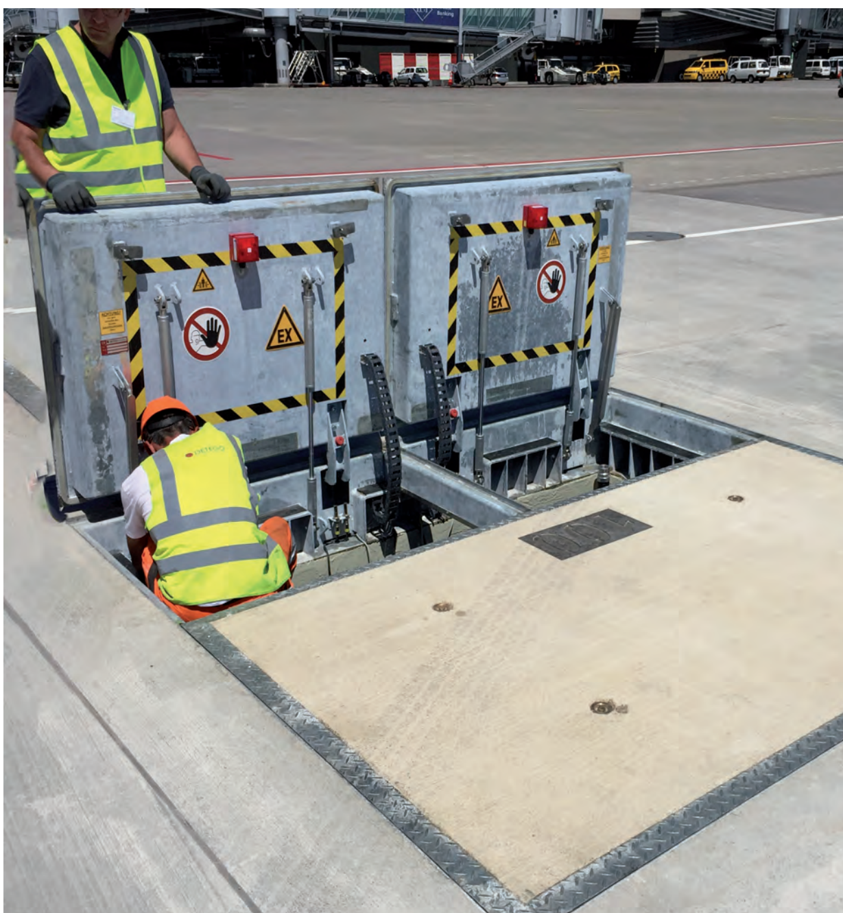
Copertura di grande superficie con due aperture di ispezione Classe F 900
