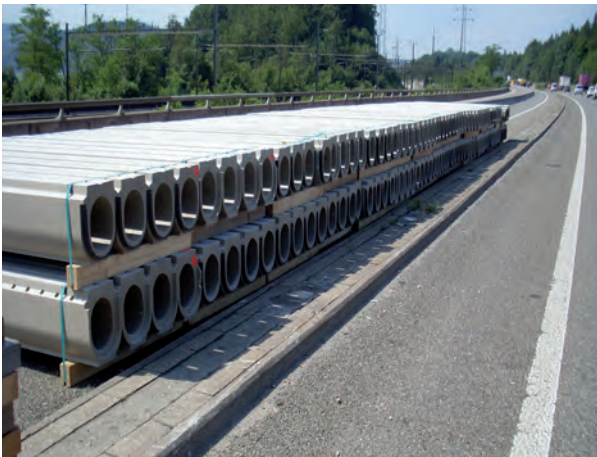
Canaletti a fessura per l'autostrada
