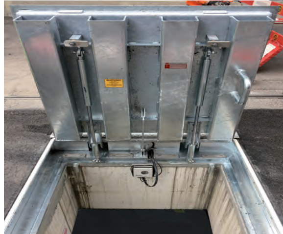
Uscita di emergenza con riscaldamento della fessura del giunto, thermostat
