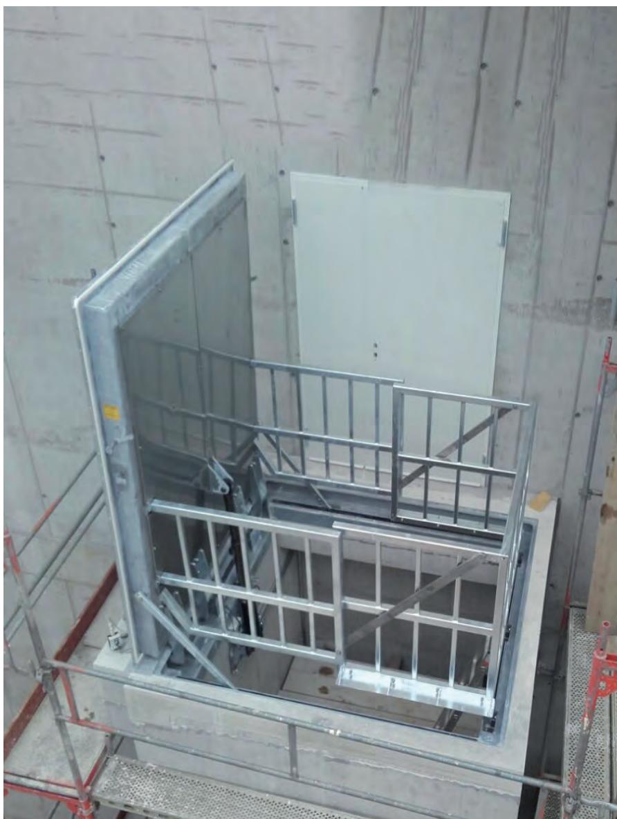
Portello di evacuazione fumi RWA con apertura automatica
