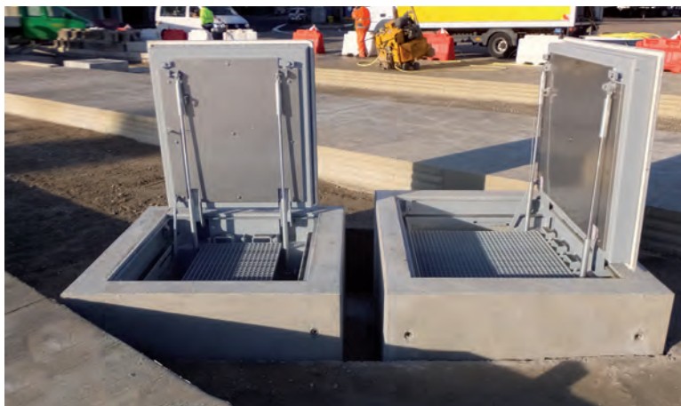
Portello di evacuazione fumi RWA con apertura assistita
