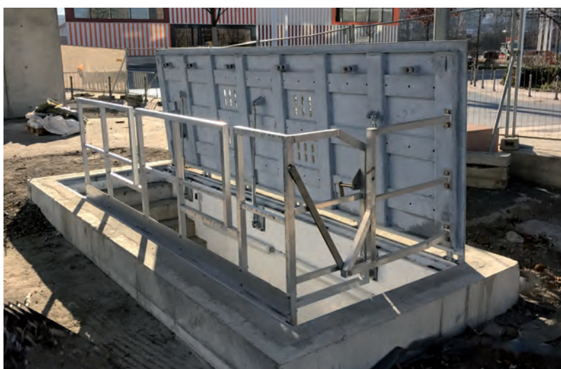
Porta a pavimento accessibile con apertura assistita
