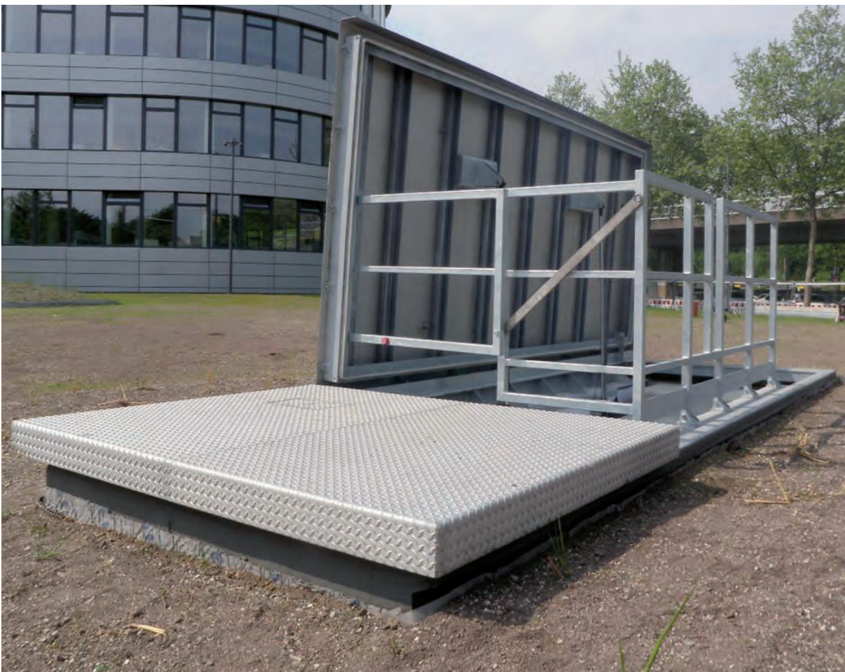
Uscita di emergenza su fabbricato
