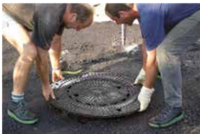
Mettere il chiusino per pozzetto completo
