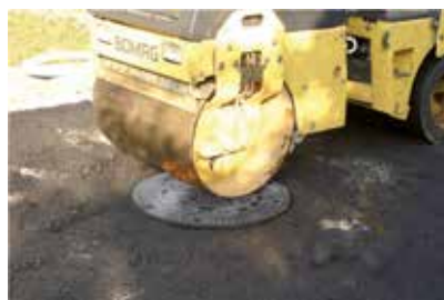
Cilindrare il chiusino a filo della superficie mediante rullo
