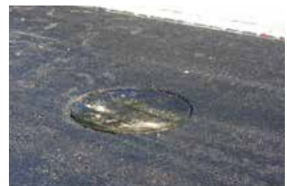
Allentare il telaio dallo strato legante (binder), ricoprire con lamiera, applicare lo strato di copertura
