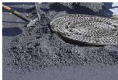
Uniformare il rivestimento adiacente a filo della superficie mediante l'applicazione di miscela bituminosa a caldo
