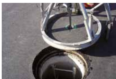
Tagliare il mento stradale e rimuovere il coperchio
