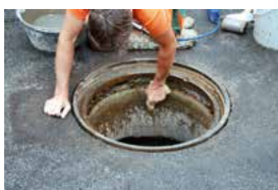
Pulire e inumidire il coperchio sollevato
