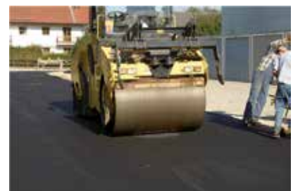
Cilindrare il chiusino a filo della superficie mediante rullo
