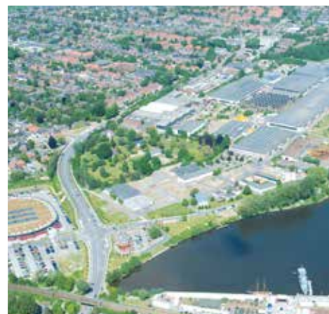
Sede centrale del Gruppo ACO in Rendsburg/Büdelndorf
