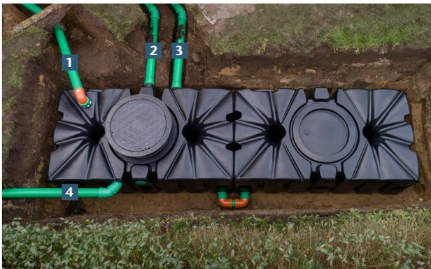
Esempio di struttura di una cisterna per l'acqua piovana da 4.000 litri con utilizzo come serbatoio di ritenzione e stoccaggio dell'acqua piovana
